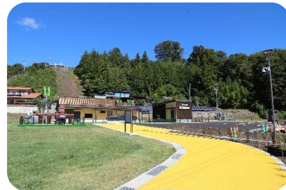
西天竜発電所・西天でんでん広場
